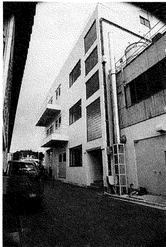
図1 城南処理センター新設建屋 (手前は旧処理場)
